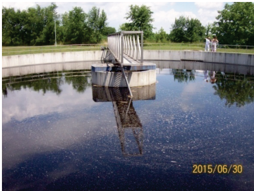
Слика 46: Дог-ов згушњивач са периферним погоном грабуља
