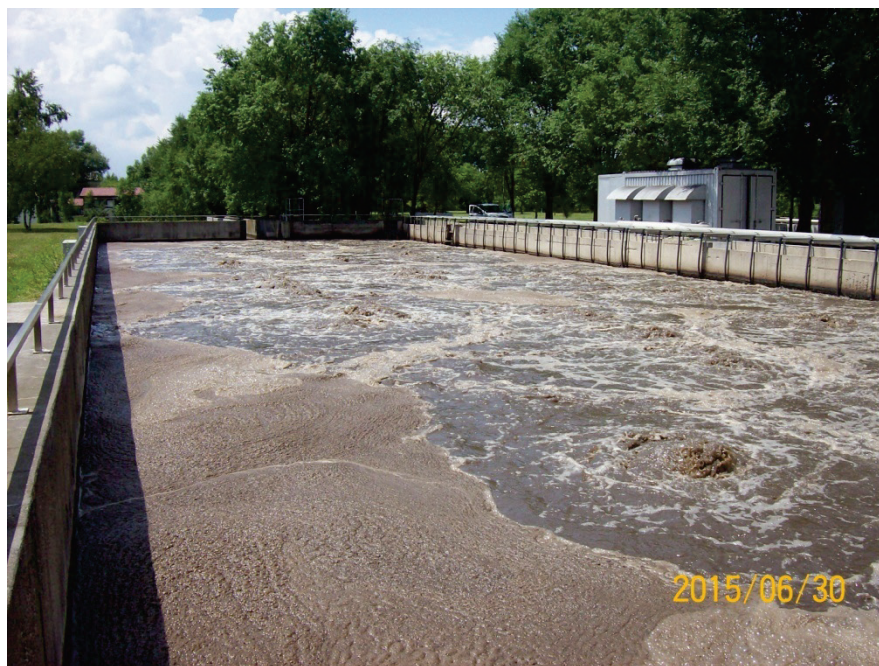
Слика 45: Хоризонтални таложник у ППОВ
